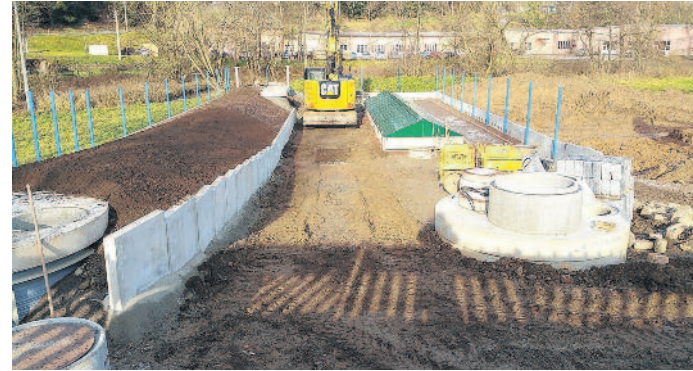
Neubau der Kläranlage in Raschau-Markersbach im Ortsteil Langenberg für 550 EWG (Einwohnergleichwerte)
