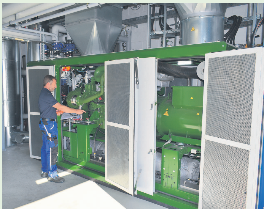
Der stellvertretende Meister Jan Wendler bei der Einstellung des neuen BHKW.
