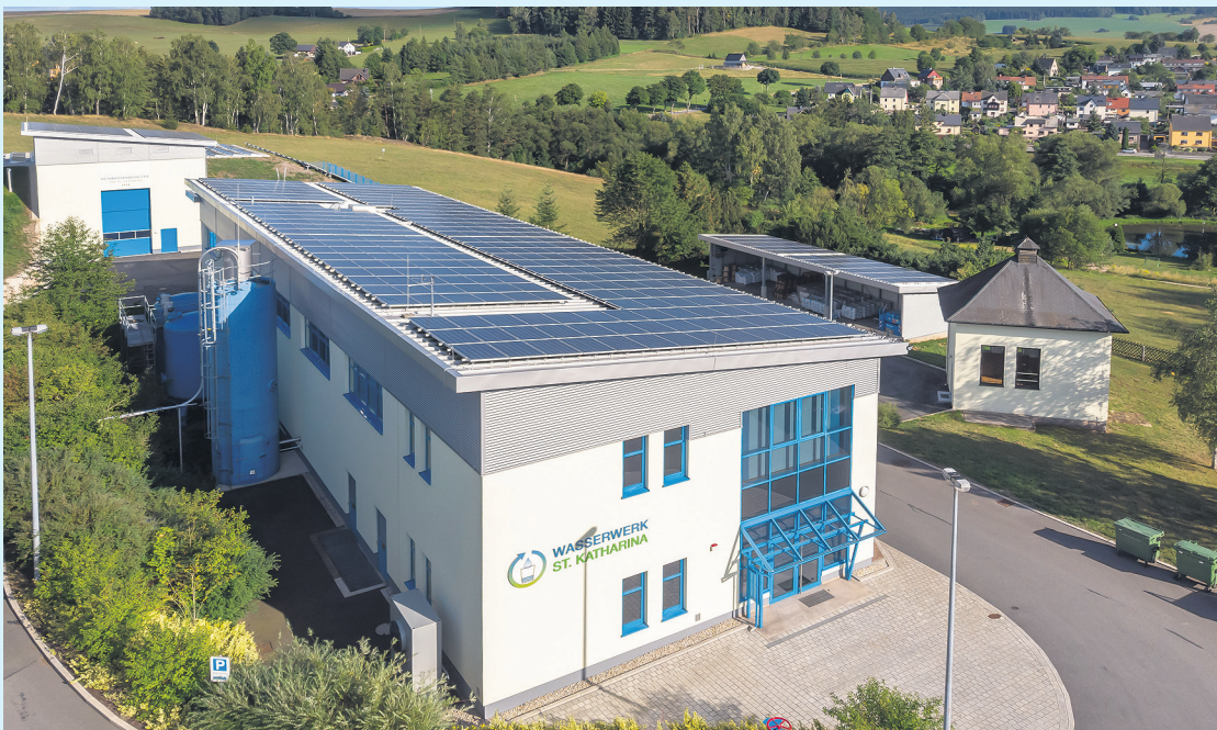
Hier im Wasserwerk „Sankt Katharina“ in Langenberg wurde die Förderung des Trinkwassers von täglich 1.350 m 3 auf 1.640 m 3 erhöht. Von hier aus wird auch die in 2020 in Betrieb genommene neue Trinkwasserverbindungsleitung nach Elterlein beschickt.
