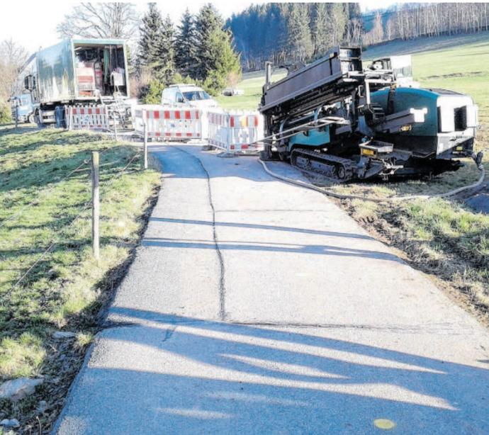
Mittels Bohrspülverfahren wurde eine ca. 1.200 Meter lange Trinkwasserleitung mit einem Nenndurchmesser DN 100 von Langenberg bis nach Schwarzbach verlegt.
