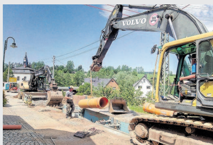
In der Elterleiner Straße in Raschau-Marketersbach OT Langenberg verlegt der ZWW derzeit für 1,75 Mio. € auf einer Länge von 670 Metern einen Mischwassersammler und wechselt auf einer Länge von 120 Metern die Trinkwasserleitung aus. Als Baufertigstellung plant der ZWW Ende November 2019.
