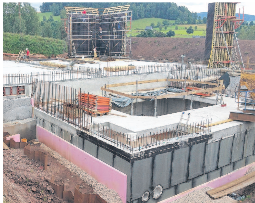
Der Bau des neuen Reinwasserbehälters im Wasserwerk Sankt Katharina geht zügig voran. Die Bodenplatte für den neuen Behälter welcher insgesamt 1600 m³ Inhalt haben wird, ist fertiggestellt. Der Rohbau soll bis Jahresende abgeschlossen sein.
