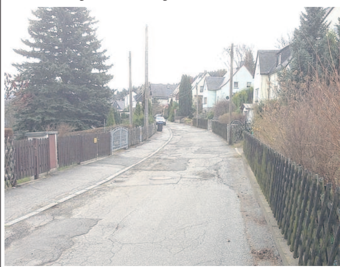
Ab 2.5. beginnen Am Becherberg die koordinierten Baumaßnahmen.
