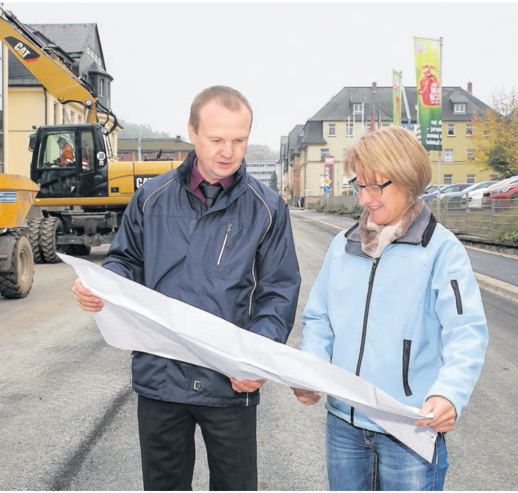
Dr. Frank Kippig, Geschäftsführer und Kati Gläser, Bereichsleiterin Trinkwasser bei der abschließenden Kontrolle der Baustelle. Foto: Katja Lippmann-Wagner
