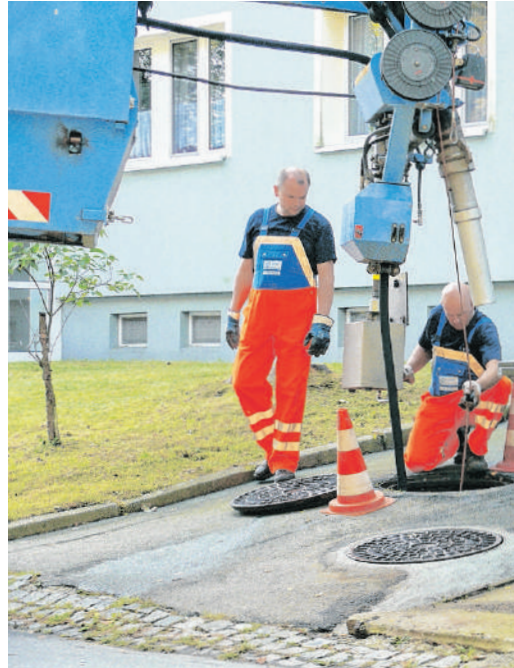
Ist das Kanalnetz oder die Hausanschlusleitung verstopft, hilft oft nur noch ein Freispülen mit dem Hochdruckspülergerät (HDS) der Wasserwerke Westergorge. Die Ursachen für solche Verstopfungen sind oft banal, die Folgen aber verheerend. Wird der Verursacher der Verstopfung ermittelt, kann dies zu erheblichen Kosten führen. Jeder einzelne kann jedoch dafür sorgen, dass es nicht so weit kommt.
