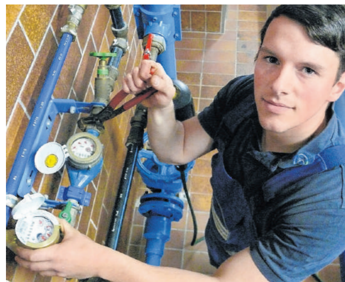
Lars Grimm, Mitarbeiter der Wasserwerke Westergorge, beim Einbau der neuen Wasserzähler.
