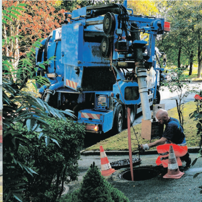
Ist das Kanalnetz oder die Hausanschlusleitung verstopft, hilft oft nur noch ein Freispülen mit dem Hochdruckspülergerät (HDS) der Wasserwerke Westergorge. Die Ursachen für solche Verstopfungen sind oft banal, die Folgen aber verheerend. Wird der Verursacher der Verstopfung ermittelt, kann dies zu erheblichen Kosten führen. Jeder einzelne kann jedoch dafür sorgen, dass es nicht so weit kommt.
