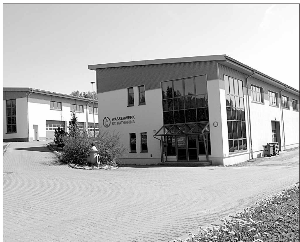
Die Verwaltungs- und Funktionsgebäude sind fertiggestellt. Nach dem Umbau der Außenanlagen kann der Umzug der Mitarbeiter von Raschau nach Langenberg im September stattfinden.
