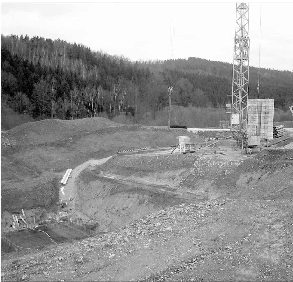
Die Arbeiten am Neubau der Kläranlage in Burkhardtendorf wurden nach der Winterpause wieder aufgenommen und sind in vollem Gange. Mit der geplanten Fertigstellung im Oktober 2011 wird dann das Abwasser von circa 2.600 Einwohnern aus den umliegenden Gemeinden gereinigt.
